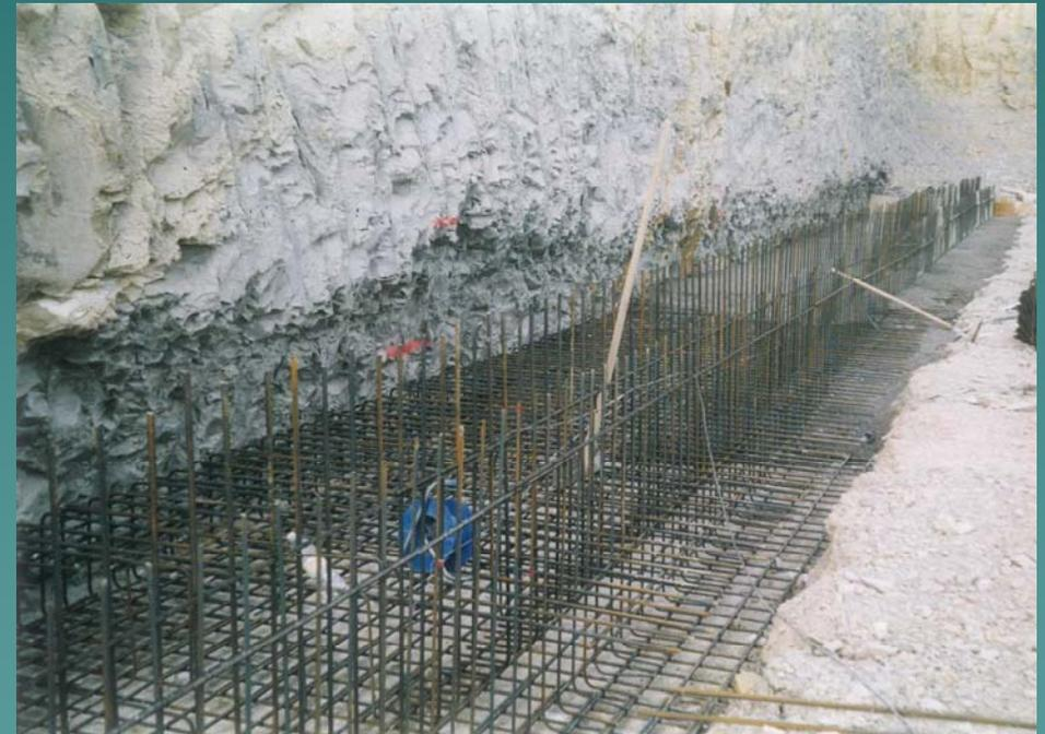
MURO DE HORMIGÓN ARMADO PARA
